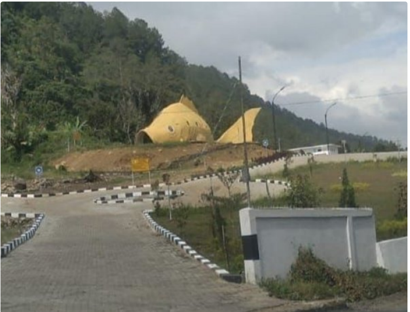
Proyek Pembangunan Ikan Mas Sipolha
